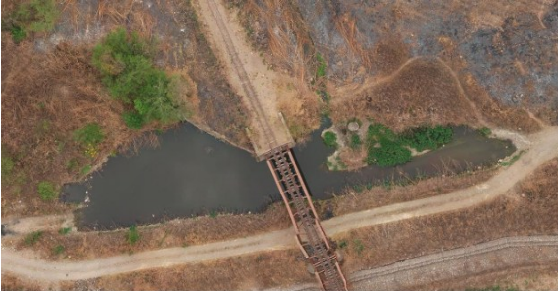
Imagen 3 - BCA Chanchillos - Acumulación de aguas servidas
